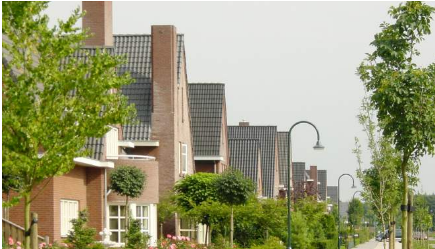
verspringende gevels en erkers verrijken het beeld
