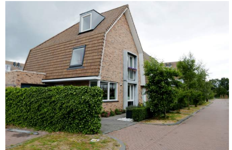
genuanceerd bont metselwerk en een pannendak
